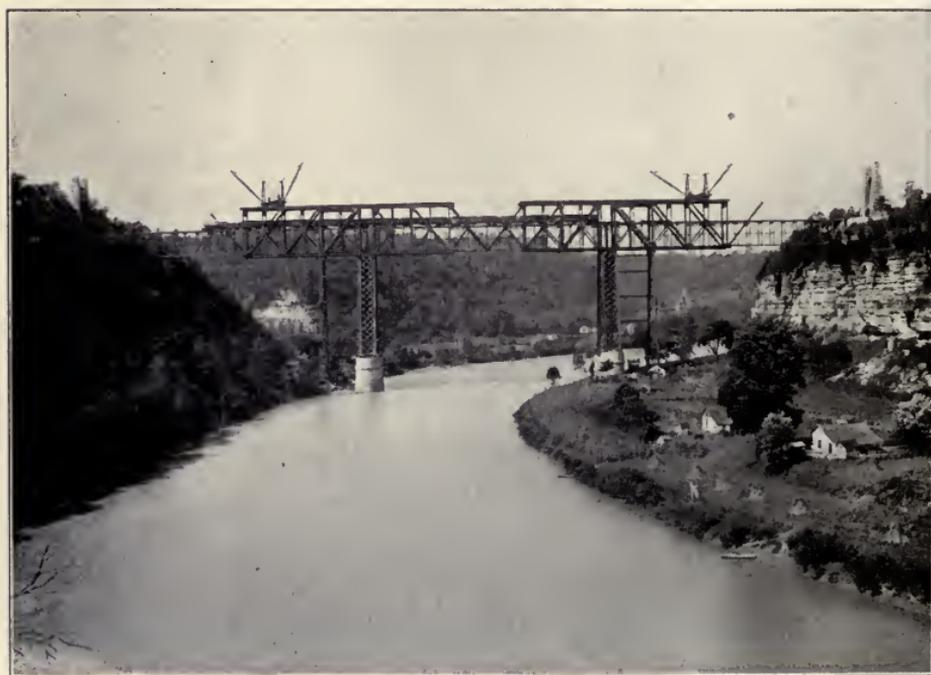
A FAMOUS CANTILEVER RAPIDLY DISAPPEARING — THE SUBSTITUTION OF A NEW KENTUCKY RIVER BRIDGE FOR THE OLD, ON THE
