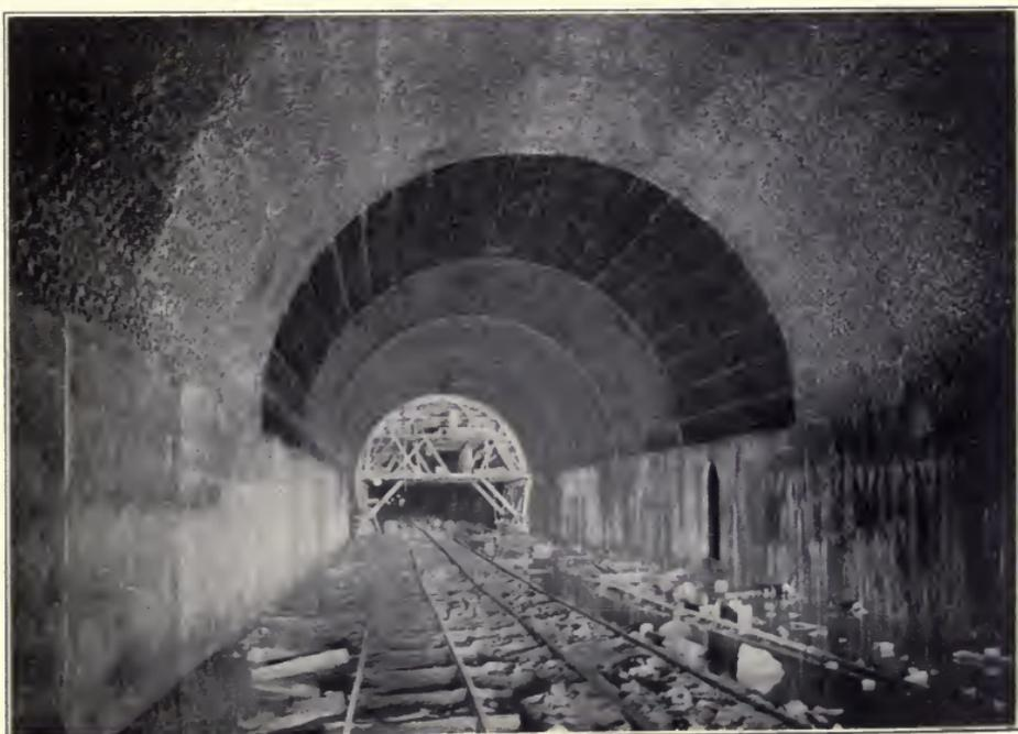
FINISHING THE LINING OF A TUNNEL
